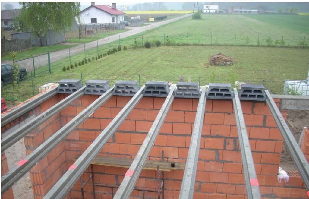
Fot. 1 Układanie belek na ścianach
