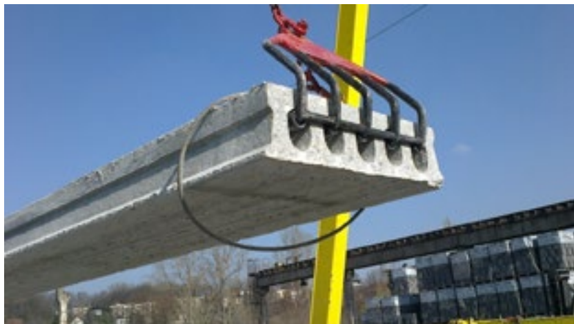
Rysunek 3. Przenoszenie paneli SMART za pomocą chwytaków
