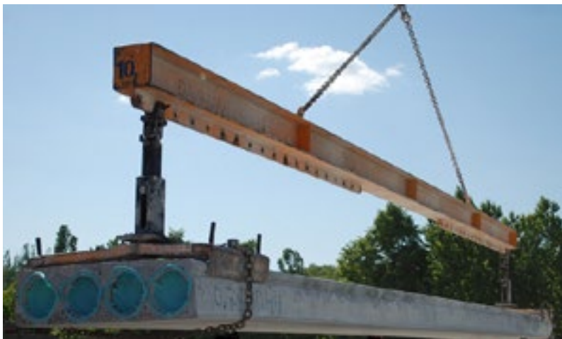
Rysunek 1. Przenoszenie płyt stropowych za pomocą trawersy
