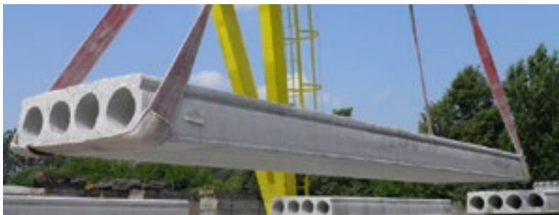
Rysunek 2. Przenoszenie płyt za pomocą pasów
