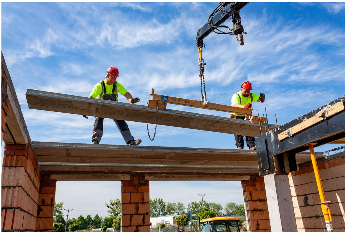
Rys. 6. Strop panelowy Teriva Panel [Źródło: www.strop-teriva.pl , dostęp dn. 24.06.2019]
