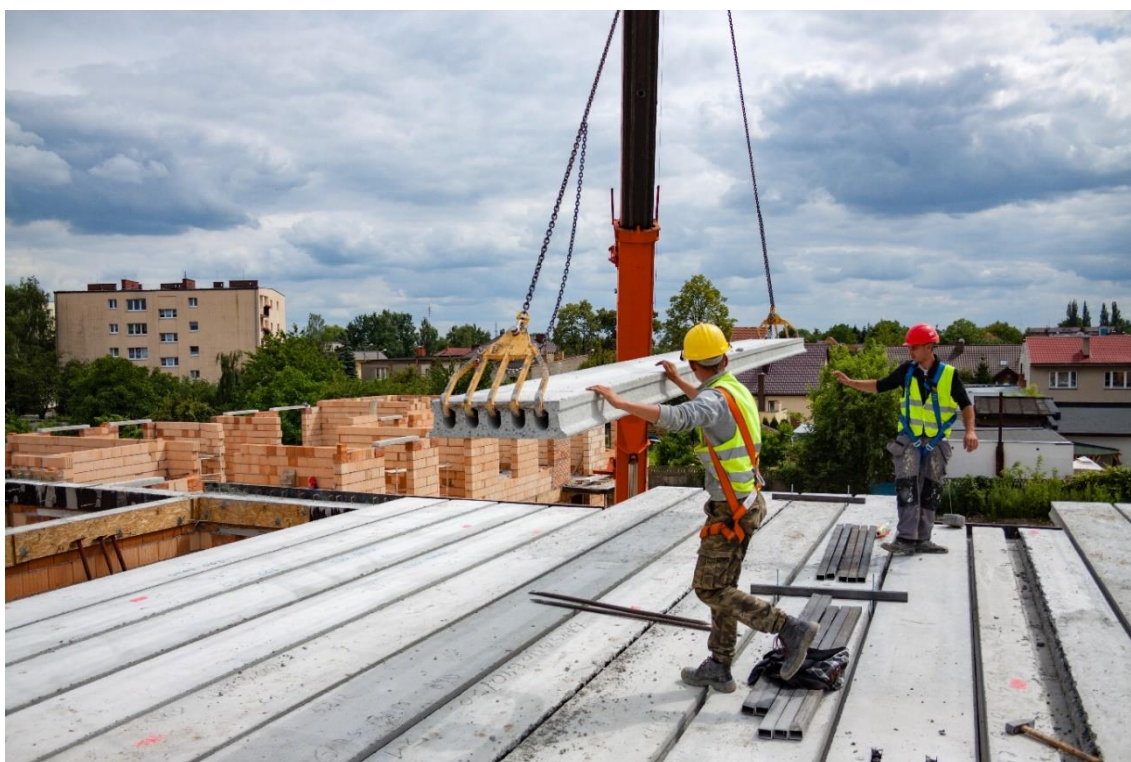
Rys. 2. Strop panelowy Smart [Źródło: 7, s. 50]
