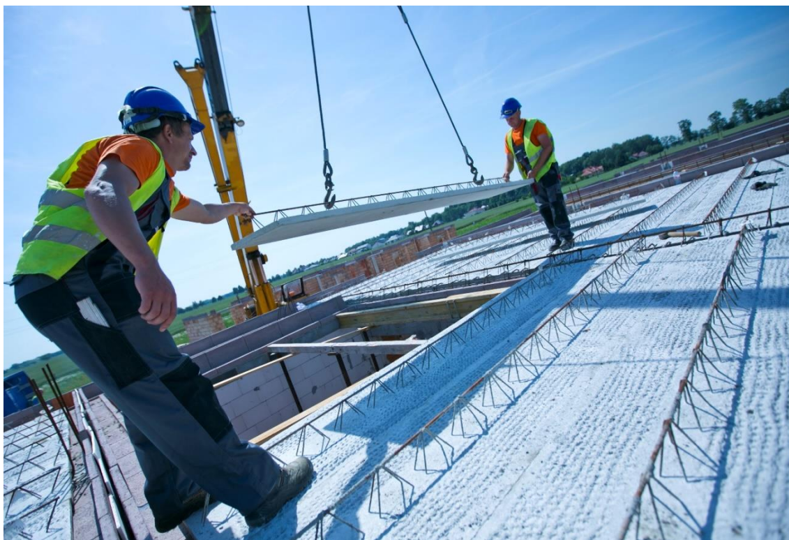
Rys. 1. Strop panelowy Vector [Źródło: 7, s. 40]
