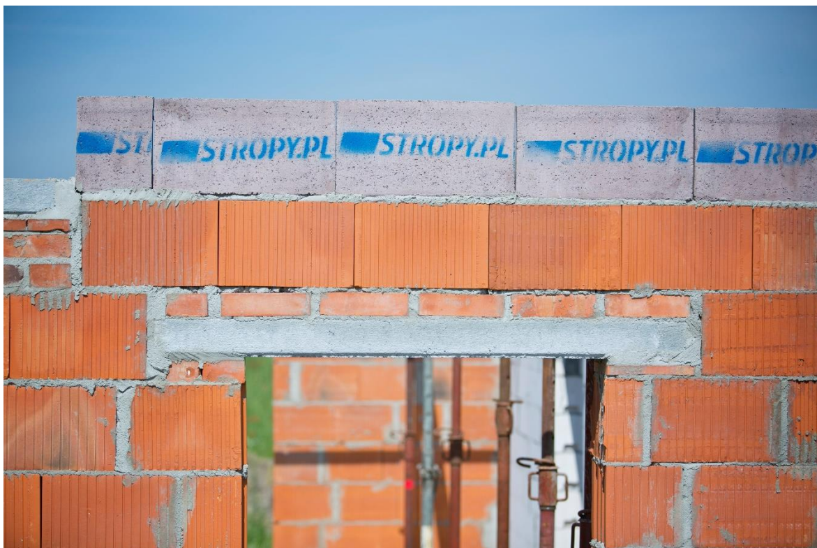
Rys. 10. Kształtki wieńcowe (szalunkowe). Źródło: KONBET POZNAŃ
