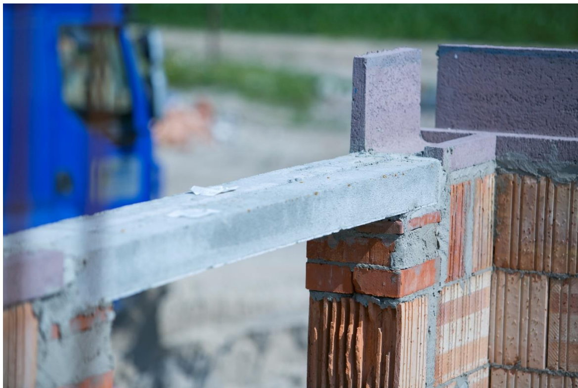
Rys. 9. Nadproża strunobetonowe. Źródło: KONBET POZNAŃ
