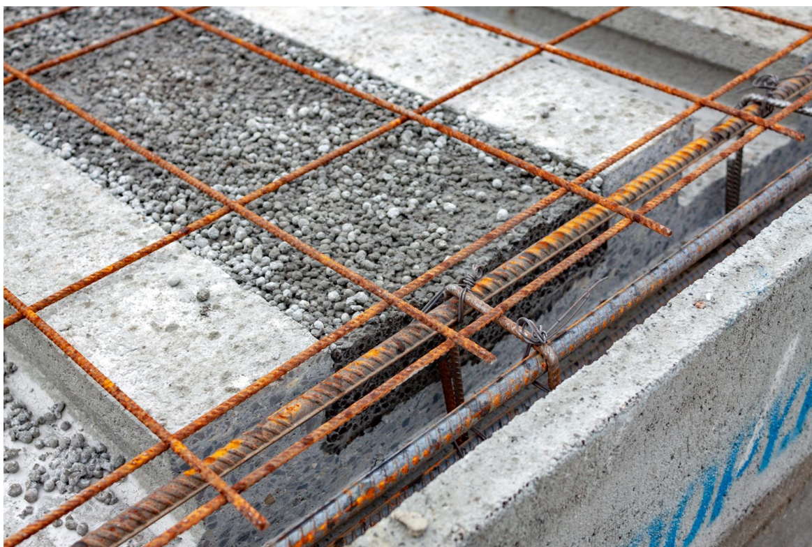
Rys. 16. Widoki wykonanego zbrojenia podporowego
