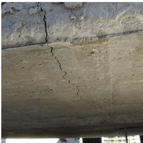
Rys. 48. Zarysowanie spodu płyty oraz obrót na podporze z zarysowaniem kształtki
