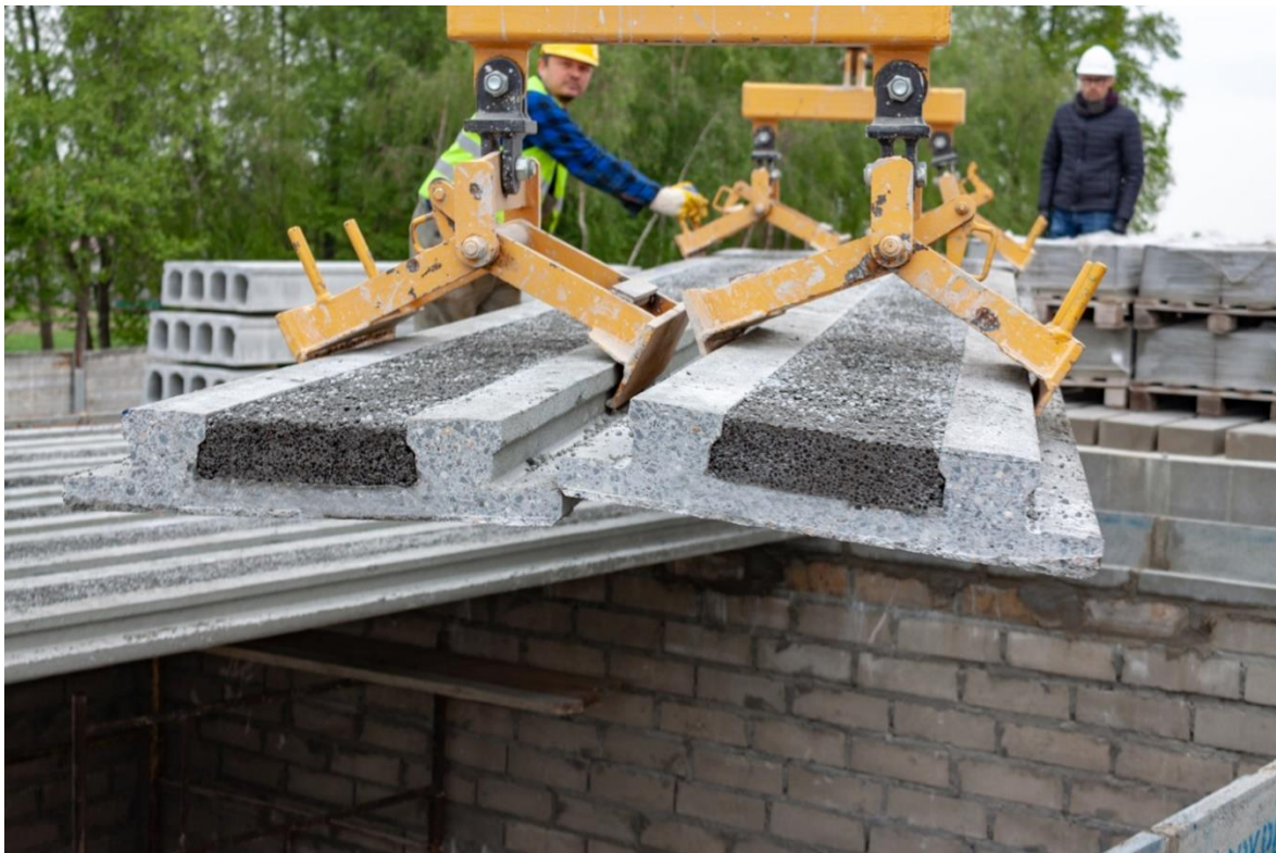
Rys. 5. Strop panelowy Teriva Panel [Źródło: www.strop-teriva.pl , dostęp dn. 11.06.2019]
