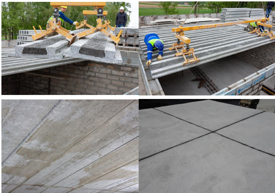
Rys. 14. Widok modelu w trakcie wykonywania i po betonowaniu
