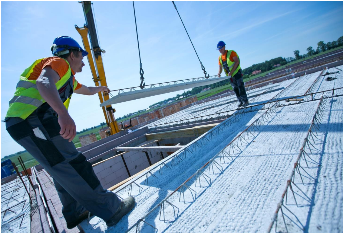
Rys. 2.11. Montaż gęstożebrowego stropu zespolonego Vector 60/20 [M-3]
