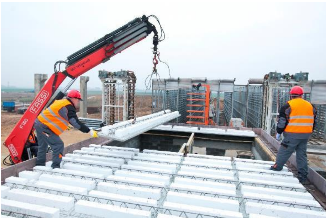
Rys. 2.12. Montaż gęstożebrowego stropu zespolonego Vector 60/20s (z kształtkami styropianowymi) [M-3]
