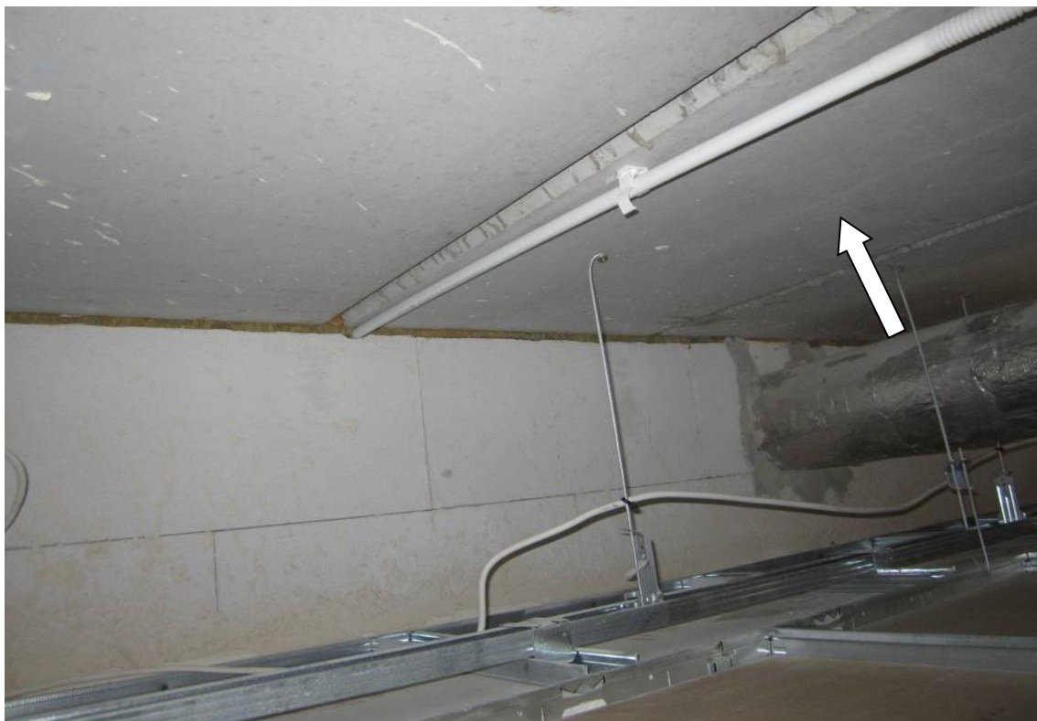
Rys. 3.8. Opuszczenie płyty zespolonego stropu typu Filigran [14]
