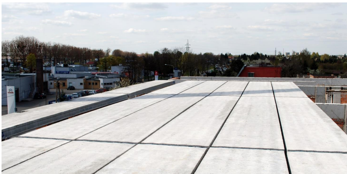
Rys. 2.20. System stropowy z kanałowych płyt strunobetonowych [I-3]
