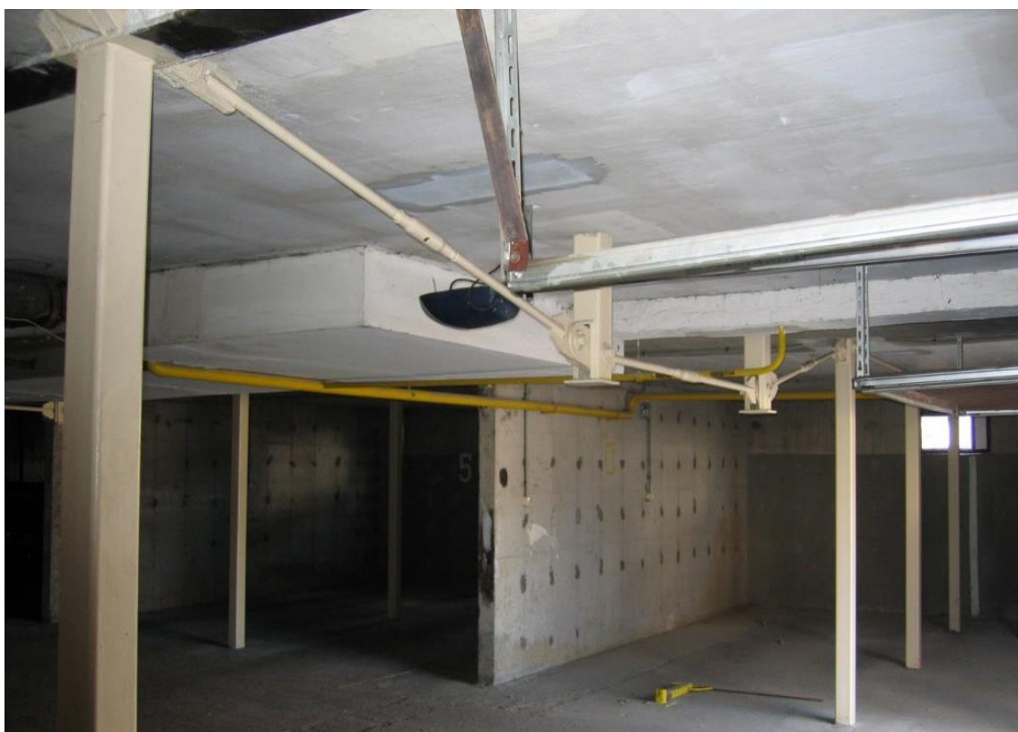
Rys. 3.9. Przykład naprawy stropu w garażu budynku mieszkalnego (wzmocnienie przez podparcie podłużnym ustrojem cięgowym w strefach parkingowej i przejazdowej) [14]
