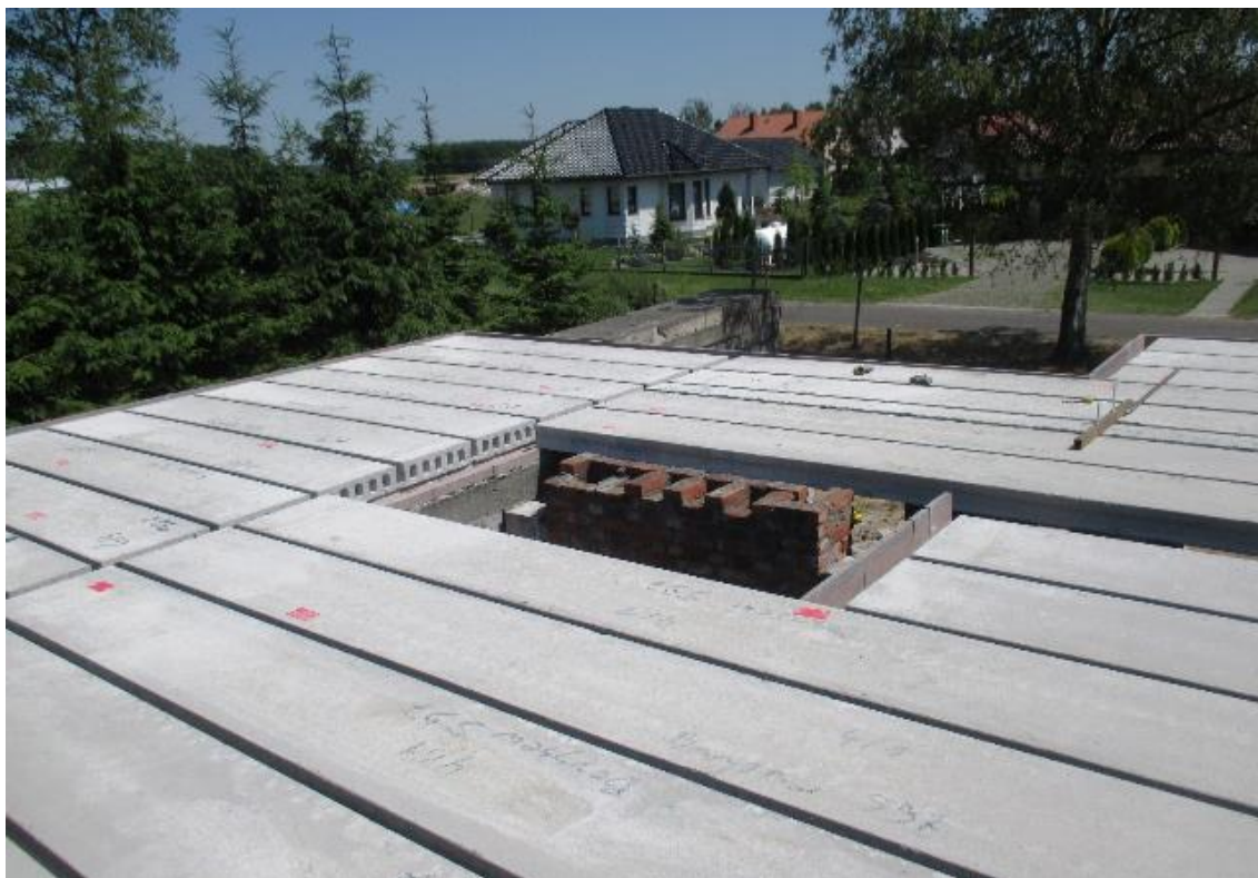
Rys. 2.15. Lekki strop panelowy SMART po zakończonym suchym montażu [M-2]
